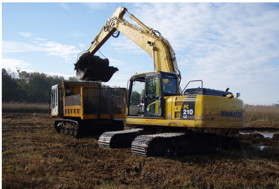
Figure 3.4.5_2 : Pelleteuse et dumper engagés dans le décapage d'une roselière intérieure
