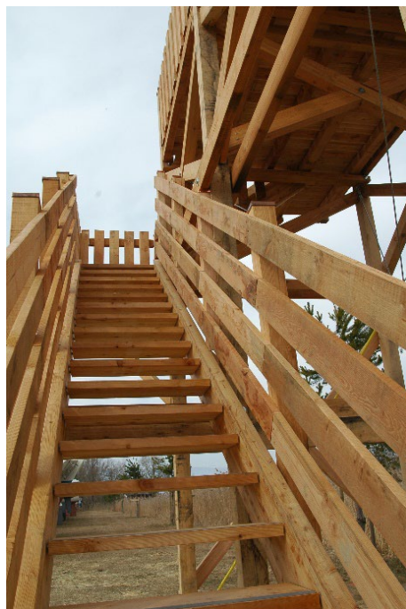
Figure E-SE_7 : Escalier sécurisé d'accès à la tour d'observation du port de Chevroux
