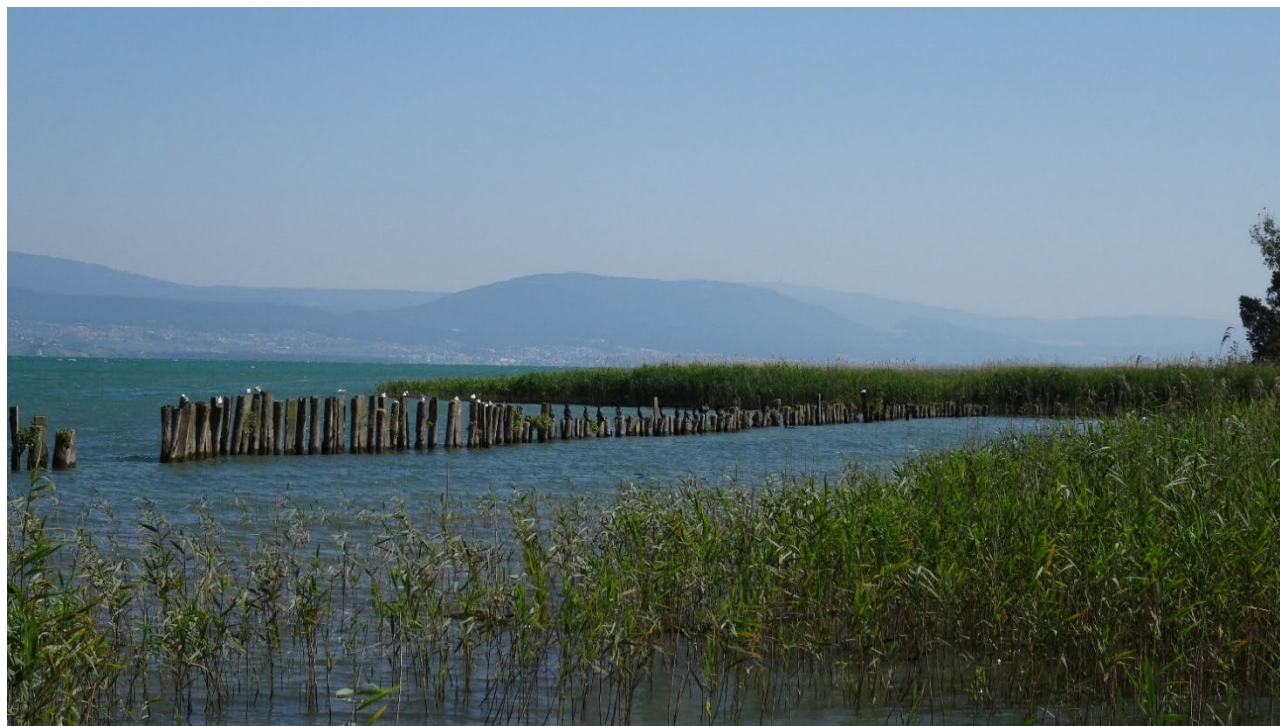
Palissade de pieux anti-érosion aménagée en hiver 1998-1999 dans la réserve naturelle de Cheyres, été 2015
