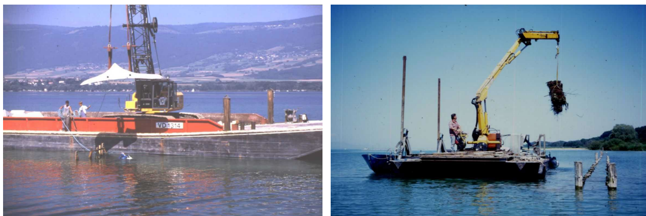
Figure E-MT_3 : Aménagement d'infrastructures de lutte contre l'érosion des surfaces marécageuses terrestres, tronçon-pilote de Cheseaux-Noréaz (VD). A gauche déchargement d'un récif artificiel. A droite pose d'une palissade à claire-voie
