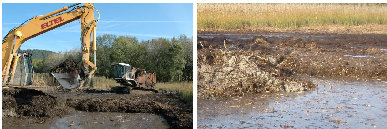
Figure E-HP_1 : Décapage de roselière intérieure. A gauche pelle retro chargeant les matériaux organiques dans la benne-convoyeuse de la machine sur chenilles ELBOTEL. A droite, matériel décapé mélangeant matière organique et anmoor
