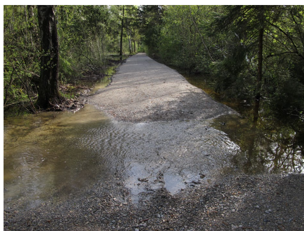
Figure E-EC_3 : Une des cunettes aménagées dans le cadre du projet de renaturation du ruisseau du Pégran dans la réserve naturelle de Cudrefin pour permettre le franchissement des eaux au travers du chemin des grèves
