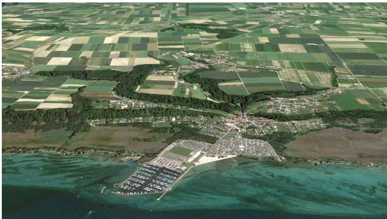
Vue aérienne du secteur du port de Portauban montrant la coupure induite dans la Grande Cariçaie et la connectivité avec l'arrière-pays
