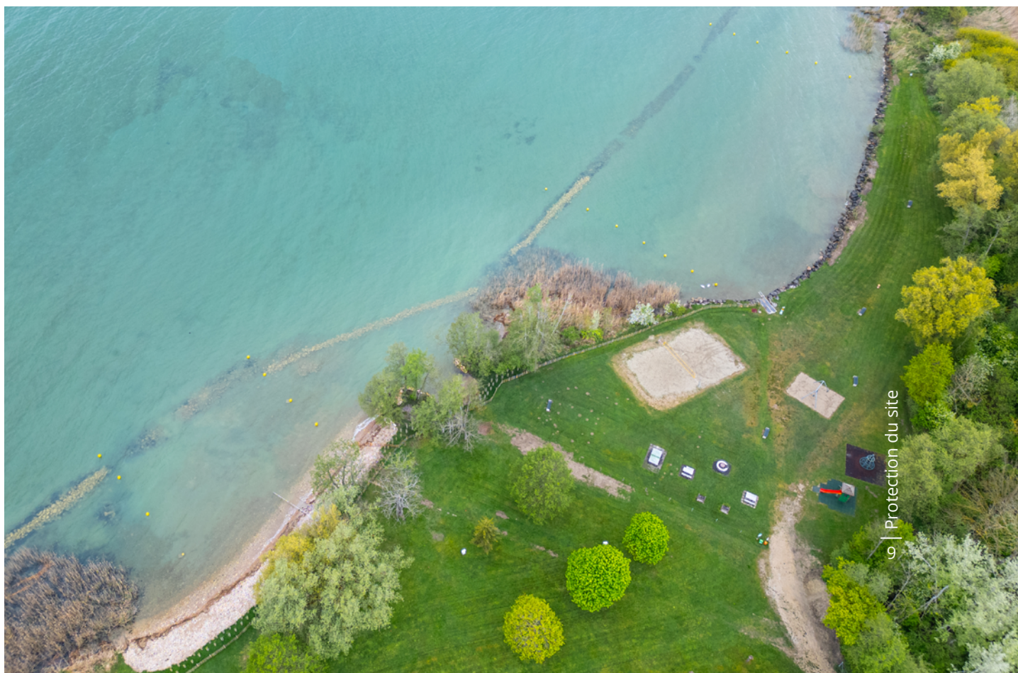
Ci-contre : Vue aérienne du projet de protection contre l'érosion de la plage de Cudrefin et la délimitation des zones de baignade pour protéger la roselière.
